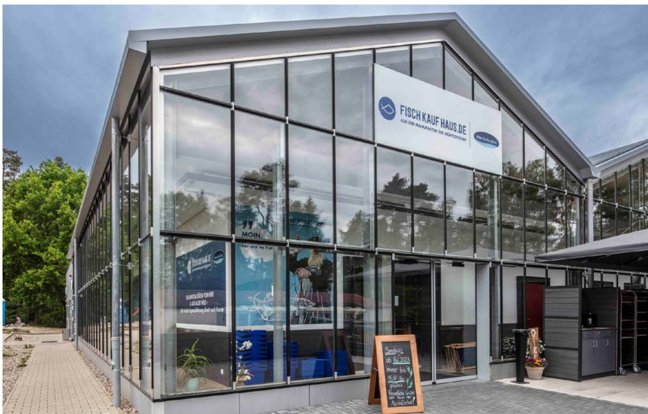
Transformation: Aus einer Aquaponik-Versuchsanlage wurde das FischKaufHaus der Müritzfischer in Waren.
